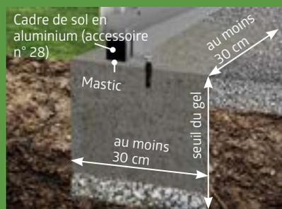
Pour fixer les abris de jardin sur un terrain irrégulier, il est également possible d'utiliser une fondation par points en combinaison avec un **cadre de sol en aluminium**.
