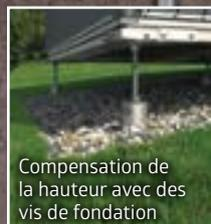
Compensation de la hauteur avec des vis de fondation
