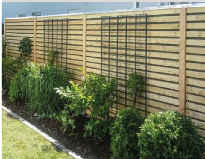
Habillage horizontal en lames trapézoïdales
