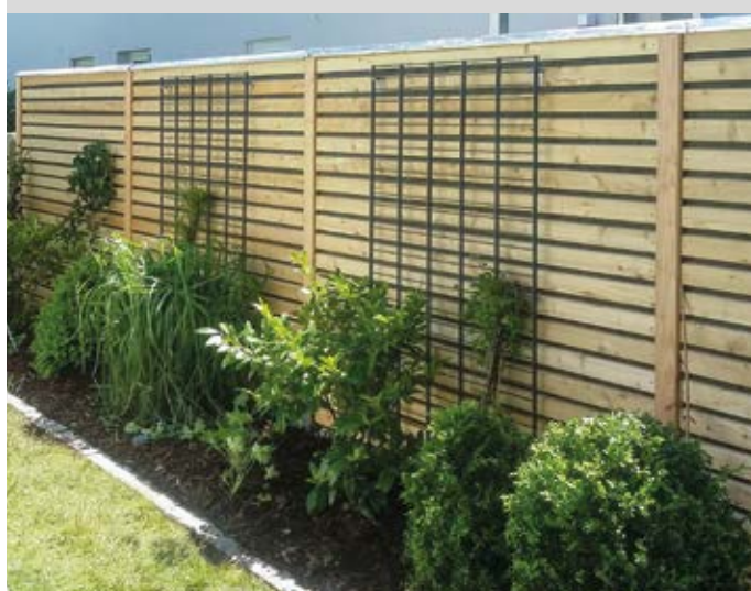
Habillage horizontal en lames trapézoïdales
